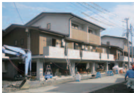
現場工事の様子 (平成25年10月30日現在)
