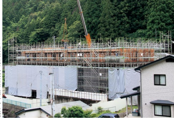
工事が進む花露辺復興公営住宅
